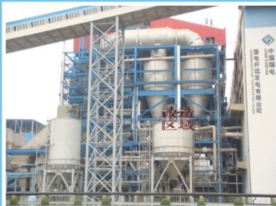
▲ 300MW机组改造
